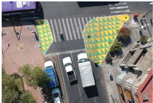
La intersección fuera de la escuela fue rediseñada para mejorar la seguridad.
