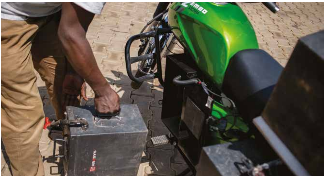
Remplacement de batterie sur une e-moto Zembo en Ouganda
